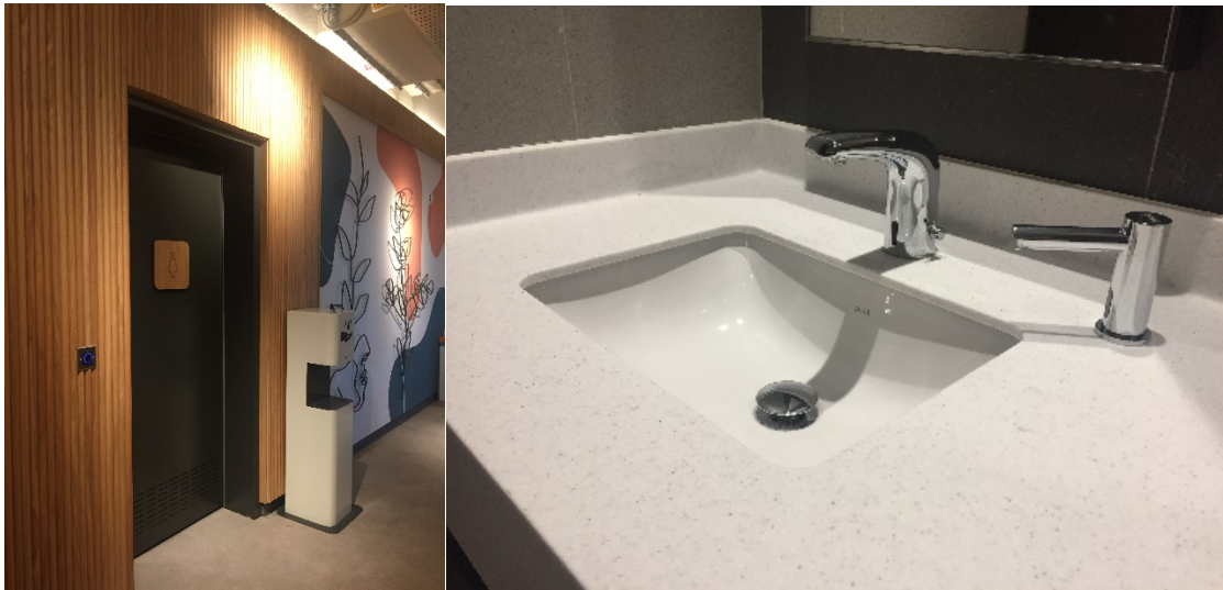
Şekil 10. Islak Hacim Kapı ve Armatürlerindeki Sensörlü Sistemler / Rönesans Holding Proje Mühendislik Departmanı Örneği
