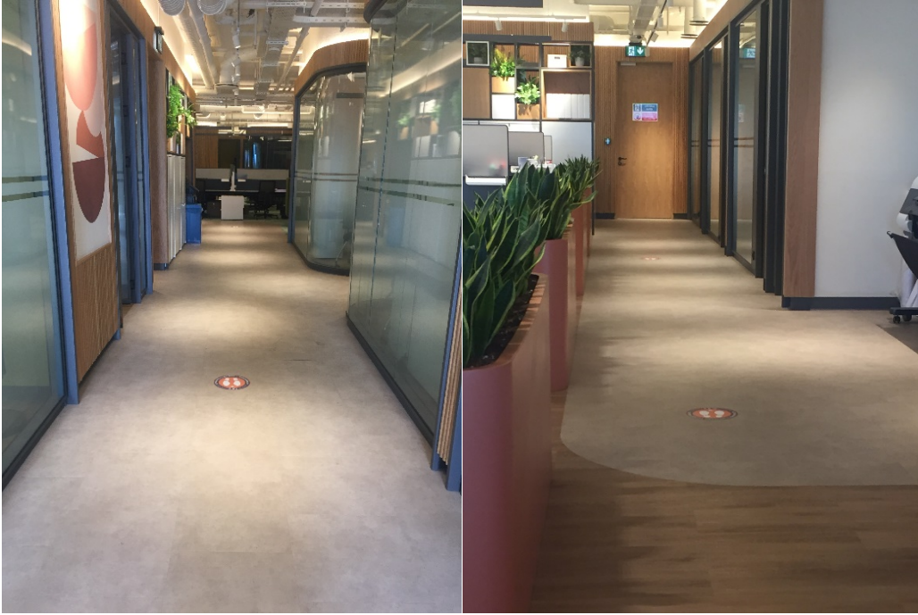
Şekil 8. Derzsiz Zemin Uygulamaları / Rönesans Holding Proje Mühendislik Departmanı Örneği
